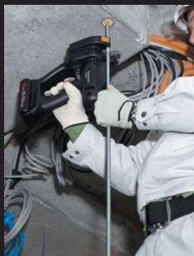
配管支持具の取付に
